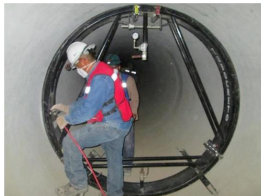
Figura 1.- Ejemplo del Joint tester (JT) y Montaje del Joint tester (JT)
